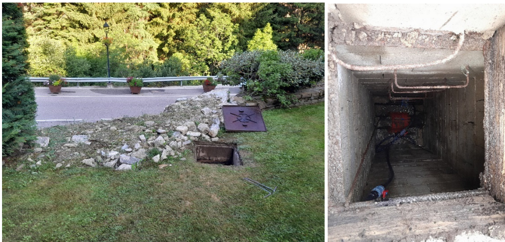
Fotografies 3 i 4. Vista de la segona arqueta, pròxima al límit inferior de la parcel·la, on s'observa les dues canonades d'abastament.
