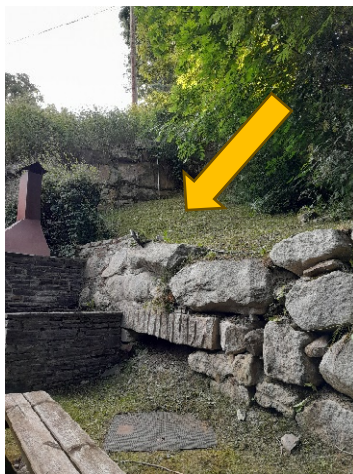
Fotografia 8. Identificació del punt on s'ha d'executar la cala de localització de les dues canonades d'abastament d'aigua existents.
