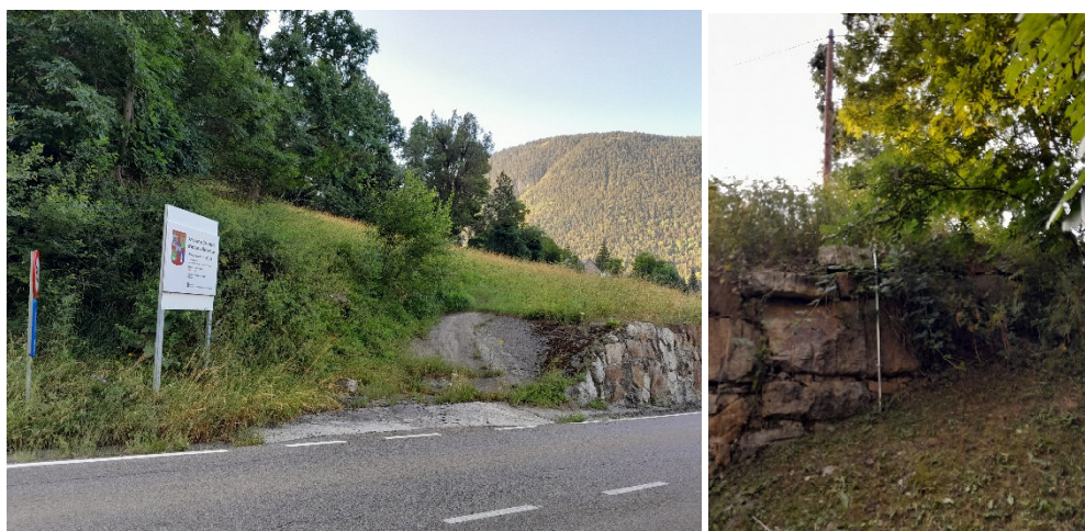
Fotografia 6 i 7. Vista del traçat de la canalització que creua la carretera d'accés a Bagergue cap a l'interior de la finca, en la seva part superior, i escullera existent.
