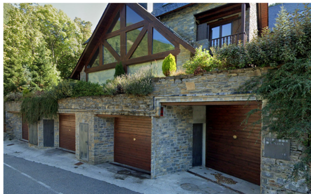
Fotografia 5. Vista de les arquetes de les vàlvules d'escomesa en l'entrada de cada aparcament dels habitatges.
