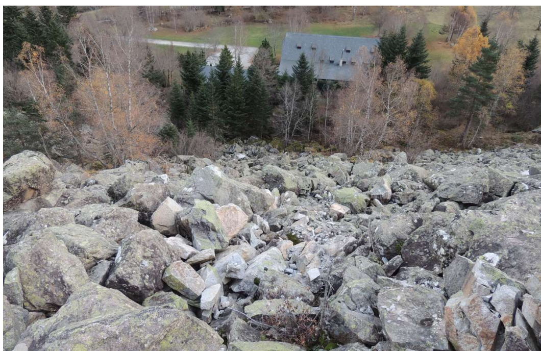
Figura 14. Impacte de bloc sobre la tartera, molt recent, amb fragmentació.
