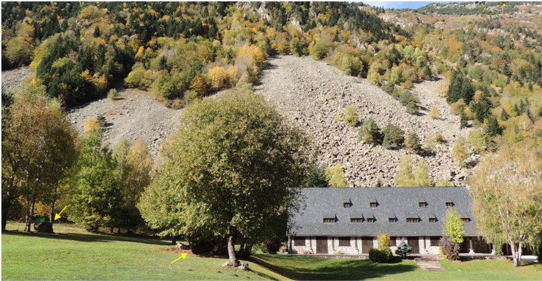
Figura 27. Edifici existent 1. A la part posterior s'observa les tarteres i els escarpament superiors rocosos font dels despreniments. A l'esquerra de l'edifici s'observa un bloc aïllat i una acumulació de blocs indicats amb fletxes grogues.
