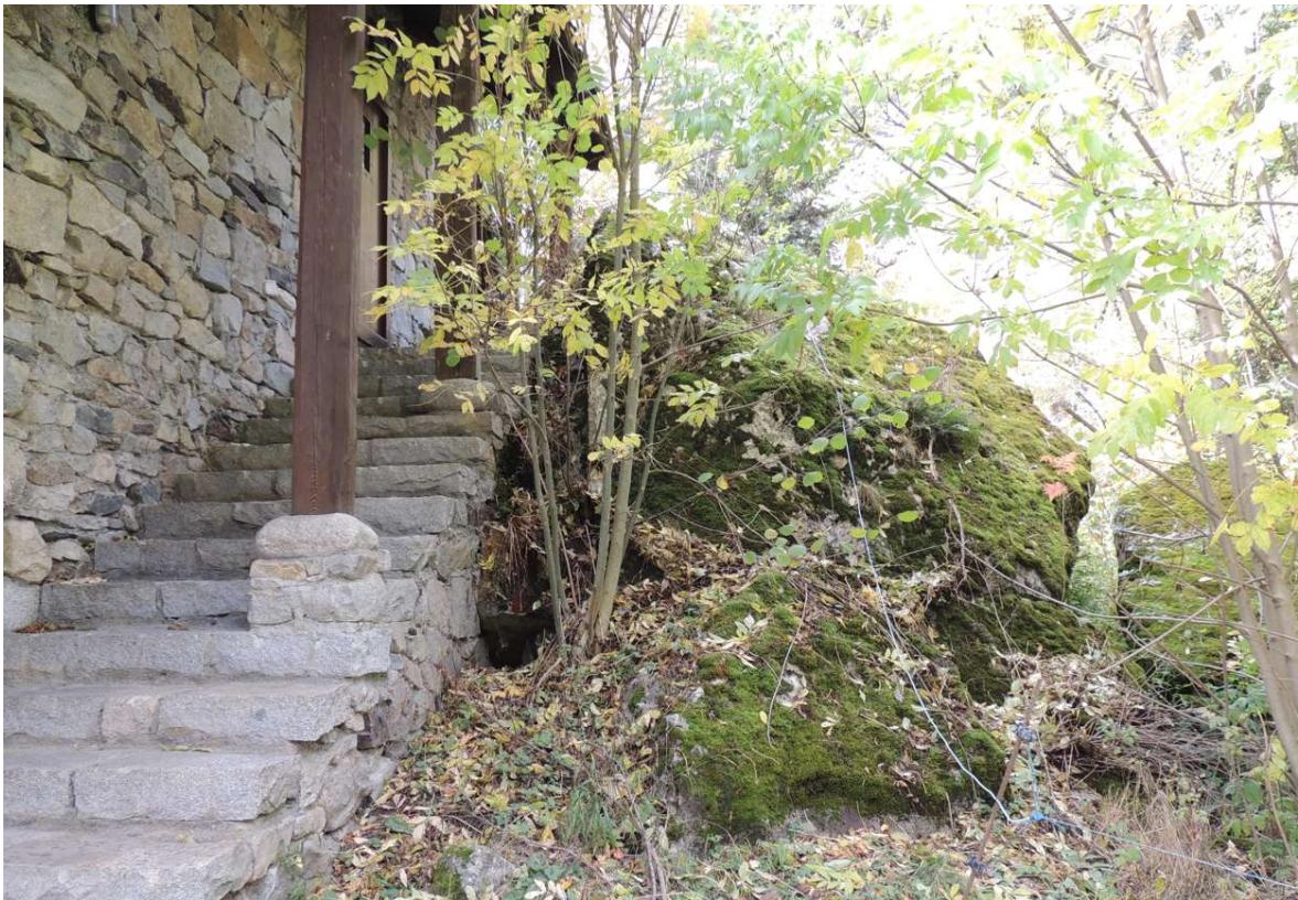
Figura 29. Blocs antics sobre els que s'ha construït l'edifici existent 2.
