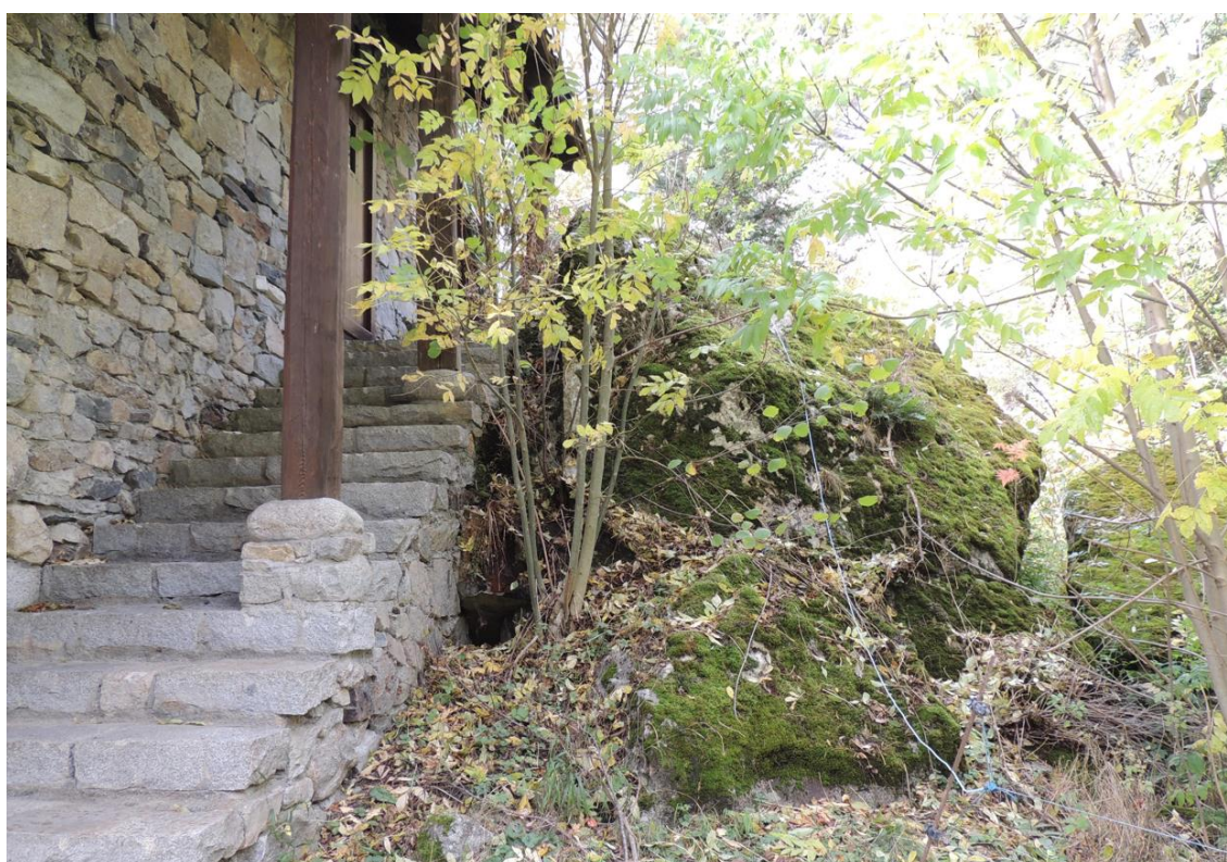
Foto 8. Blocs antics sobre els que s'ha construït l'edifici existent 2.
