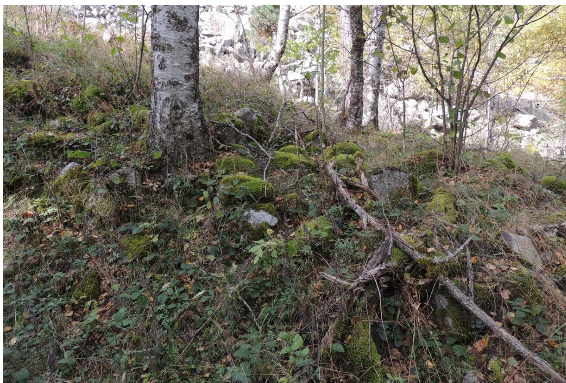
Foto 24. Part frontal del dipòsit del corrent d'arrossegalls.
