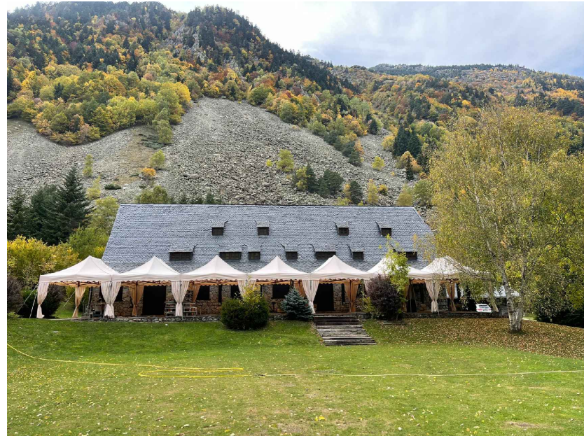
VISTA 1 (Edificació existent 1)
