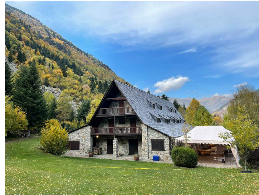
VISTA 2 (Edificació existent 1)
