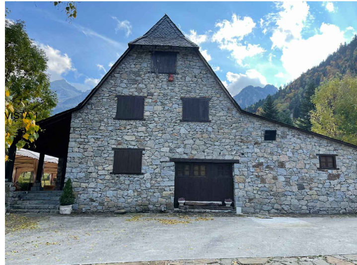
VISTA 3 (Edificació existent 1)
