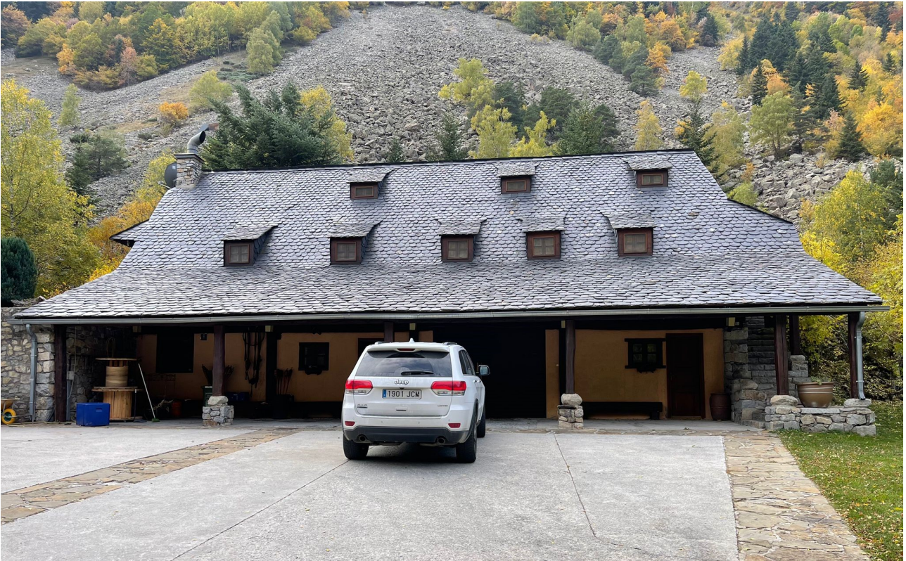
Edifici existent 2 - façana principal.
