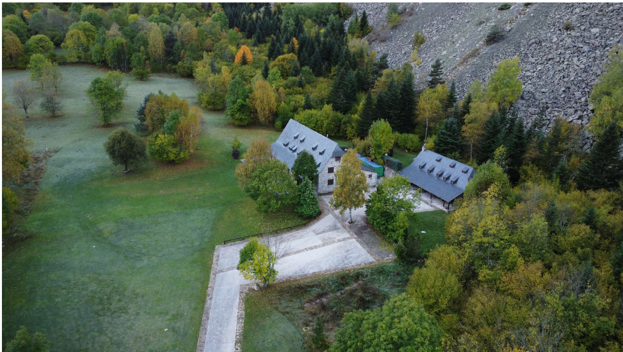
Vista d'ocell del conjunt edificatori existent.
