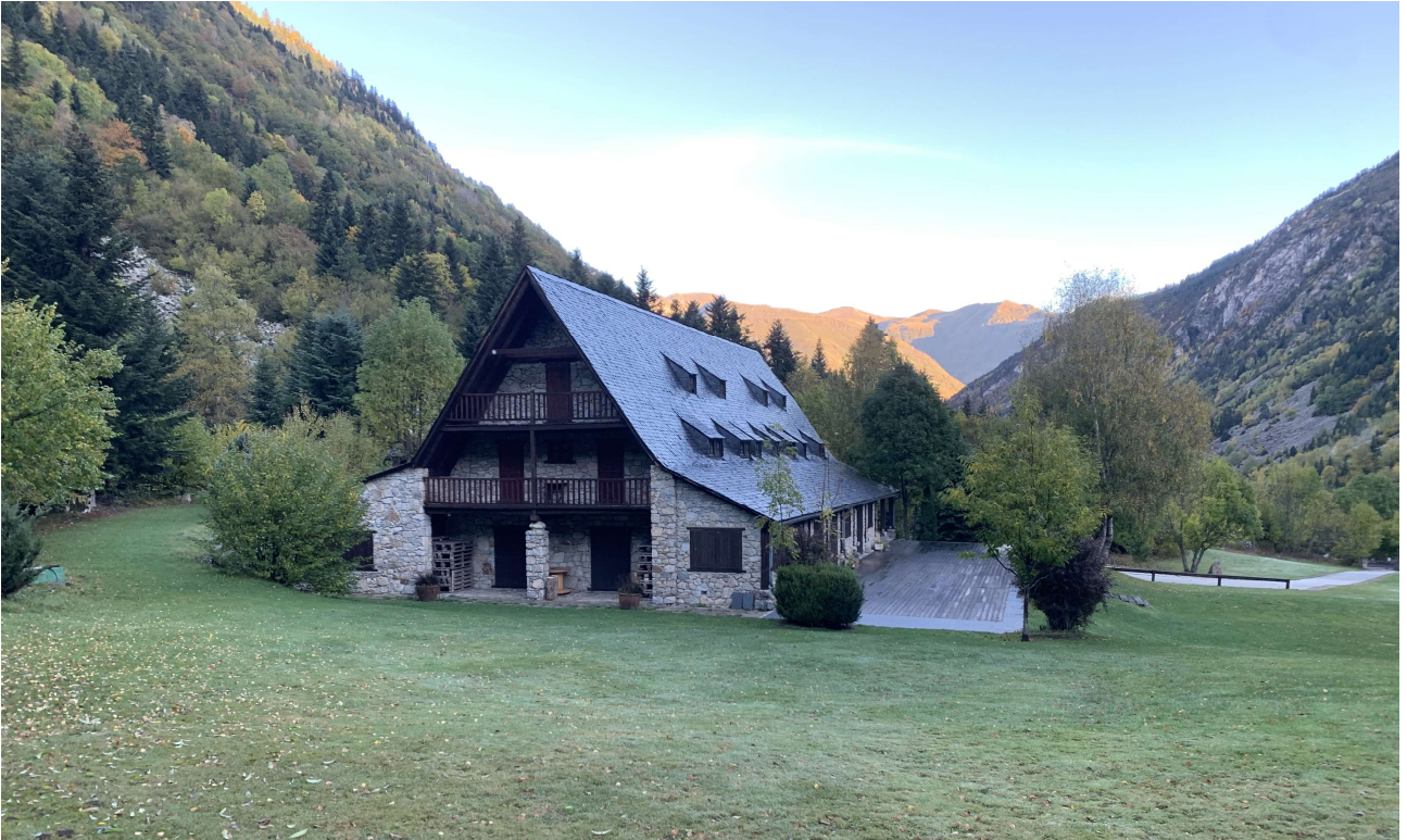
Edifici existent 1 - façana lateral.
