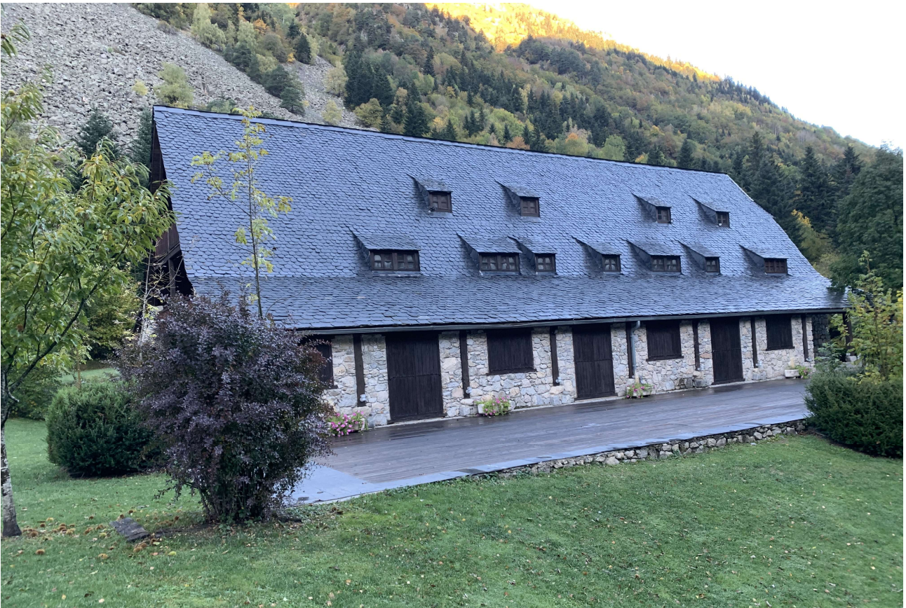
Edifici existent 1 - façana principal.
