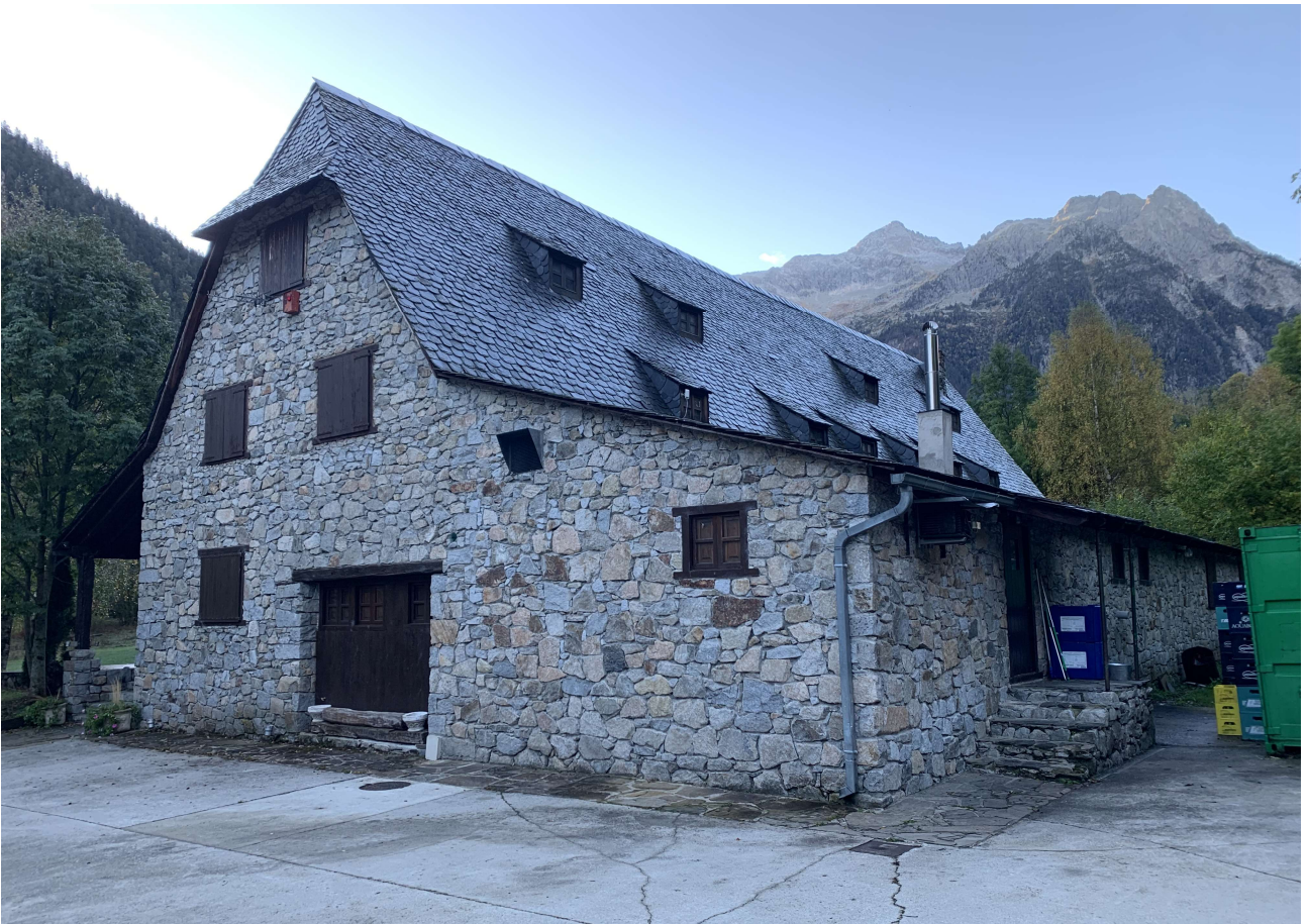
Edifici existent 1 - façana lateral i posterior.
