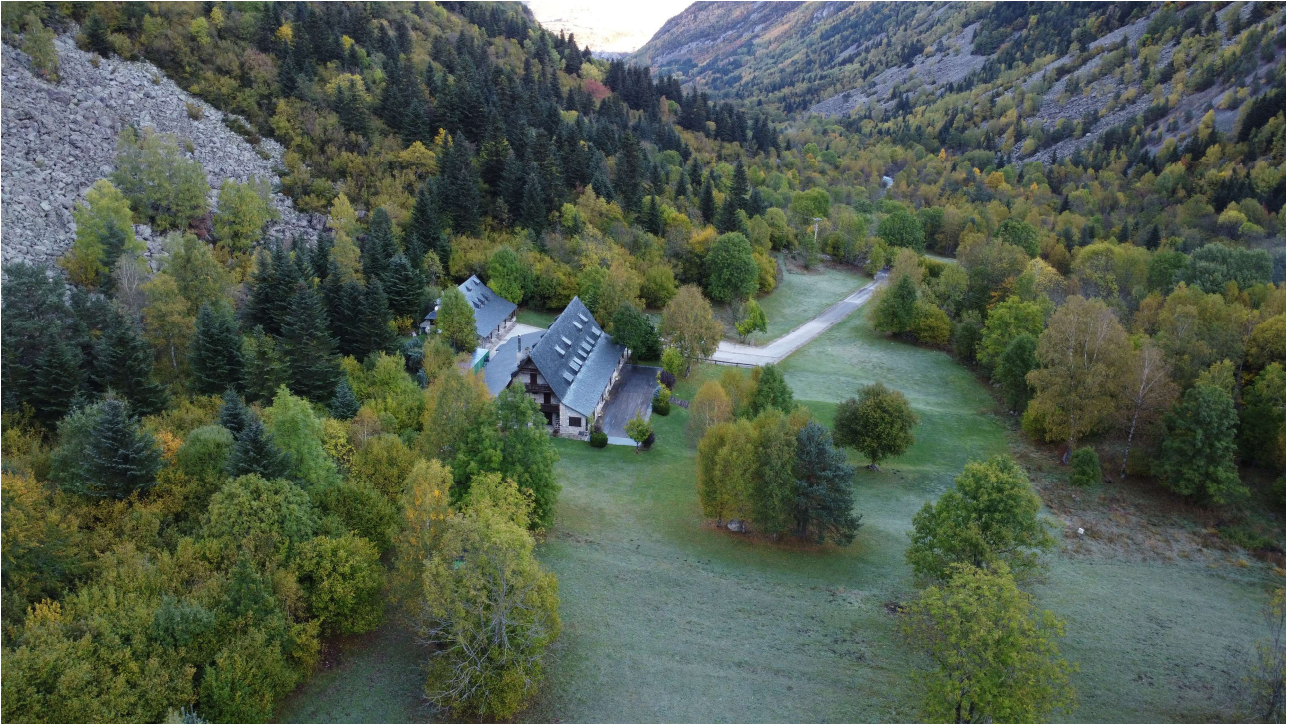
Vista d'ocell del conjunt edificatori existent.
