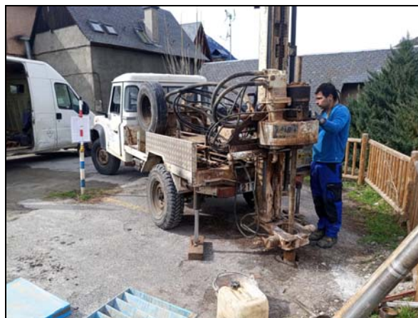
Fotografia 1. Detall de la màquina realitzant els sondeigs a rotació.
