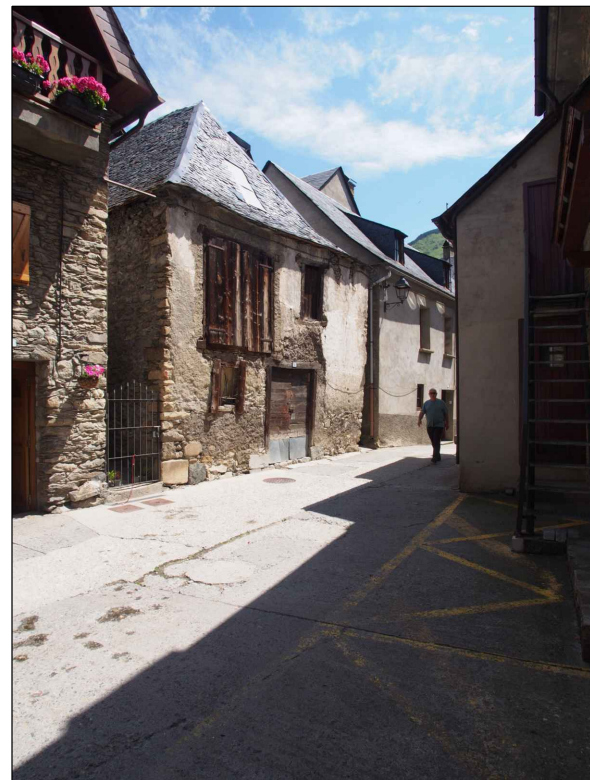
F.04 ESTAT ACTUAL - FOTOGRAFIA 04
