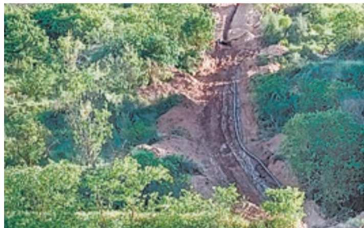
FOTO_ Aj. Camarasa Imatge de les obres actuals
