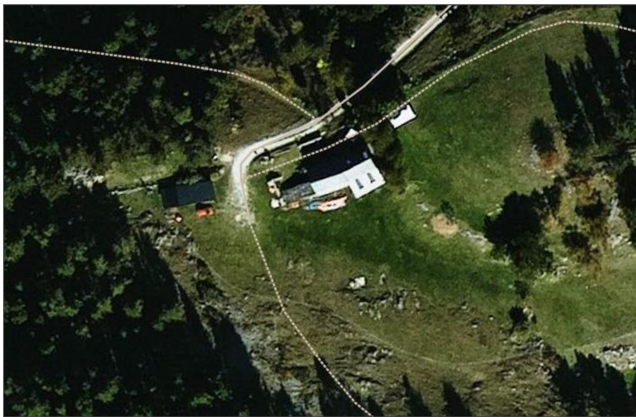
Figura 33. Massa forestal entorn de les edificacions de la Casa Vall.
